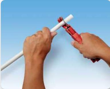
**1.** Corta el tubo en ángulo recto en una de las marcas ‘^’ asegurándote que no quedan rebabas ni ralladuras en la tubería.
