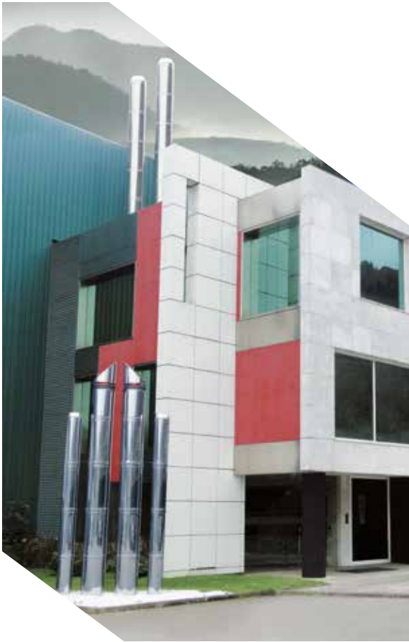
Instalaciones de Negarra en Igorre
