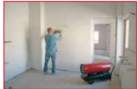
Secado de obras
