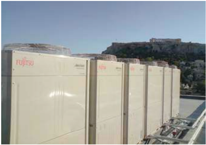
FNAC PLAKA – Atenas Grecia 6 sistemas bomba de calor AIRSTAGE V-II (Potencia instalada 360 kW)
