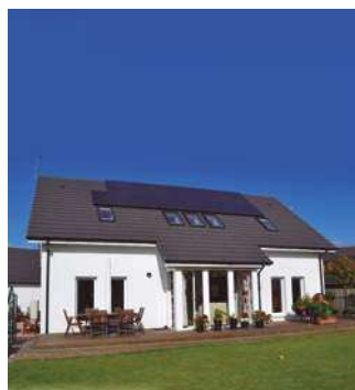
Aprovechando al máximo los incentivos para fuentes de calor renovables (RHI): éxito de la tecnología Panasonic de bombas de calor. Fife, Escocia. Aquarea
