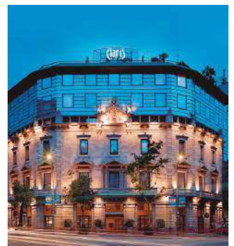
Reacondicionamiento de hotel. Hotel Claris 5*. Barcelona, España. ECOi
