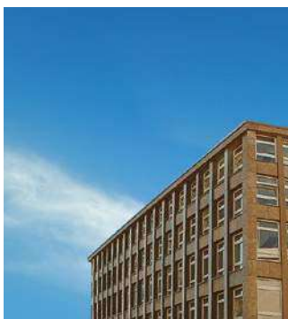
Conversión de un edificio comercial en edificio de una universidad. Bochum, Alemania. ECOi
