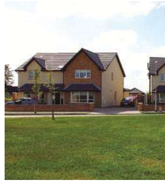
Requisitos de alta eficiencia en bajas condiciones ambientales. 21 residencias de lujo. Condado de Straffan, Kildare, Irlanda. Aquarea
