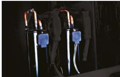
Múltiples compresores Inverter de gran capacidad (más de 14 HP).
